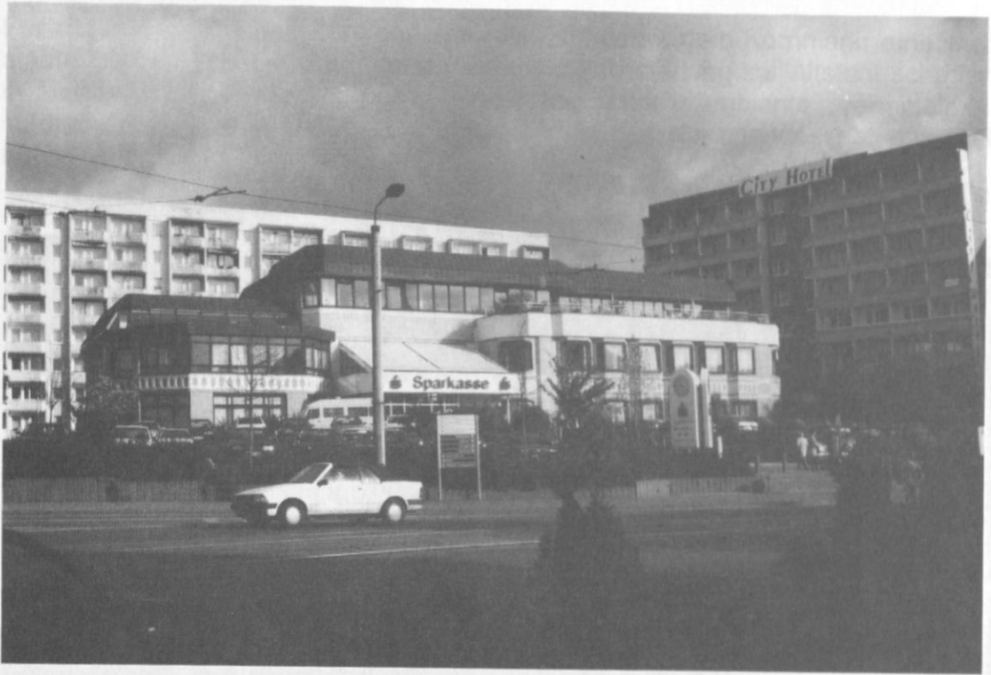
Foto 5: Die Sparkasse mit dahinter gelegener, achtgeschossiger Wohnscheibe an der Wolfstraße
